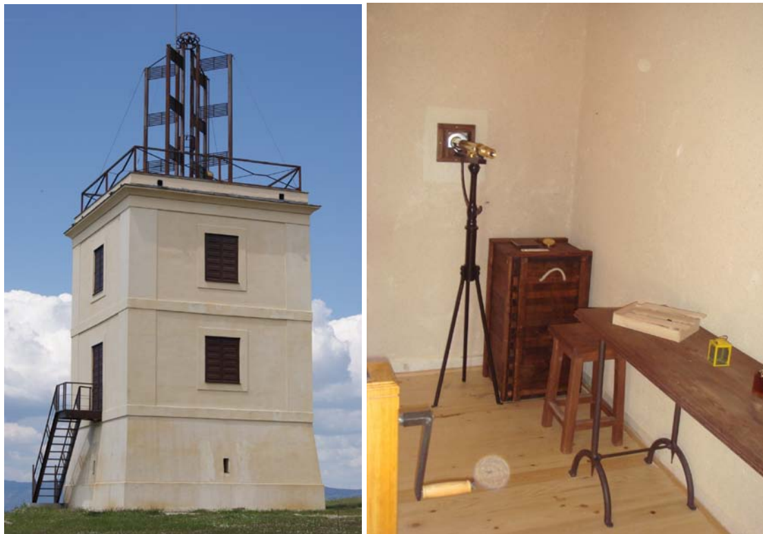
Figura 4. A la izquierda foto del exterior de la torre número 5 de la línea Madrid-Irún, sita en “Monterredondo”, Moralzarzal, Madrid, y a la derecha, foto del interior de la torre número 4 de la línea Madrid-Valencia, sita en “Campillo”, Arganda, Madrid. (Fotos actuales tomadas por el autor).
