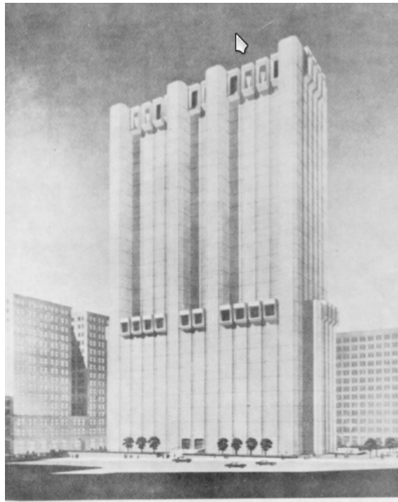
Figura 2. AT&T Long Lines Building, Nueva York, 1974, John Carl Warnecke & Associates. Boceto publicado en el documento “Long Lines Plans for Survivable Communications”, como ejemplo de edificio diseñado para operar tras un ataque nuclear. [AT&T, 1974, p. 16], cortesía del archivo histórico de AT&T. De los tres cuerpos previstos, el de la izquierda no llegó a construirse.
