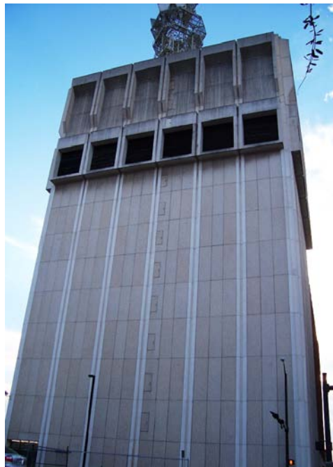
Figura 3: Torre de AT&T, Jacksonville (Florida), 1972, Reynolds, Smith & Hills. Imagen de agosto de 2006, con la ampliación en altura de dos plantas. Pueden verse, con dificultad, las puertas de carga en el centro de la torre, únicas aberturas al mundo exterior. Colección propia del autor.
