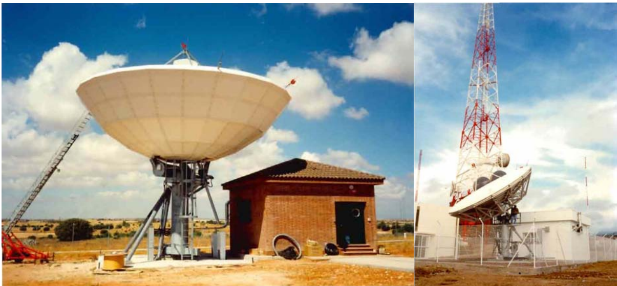
Figura 2. Estación de Anclaje en proceso de instalación y pruebas a la izquierda y Estación Satélite de tránsito en tareas de mantenimiento a la derecha. (Fotografías del autor).
