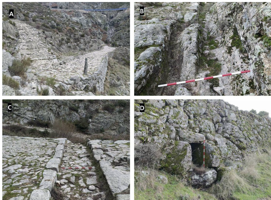
Figura 9. Distintos elementos constructivos en el Puerto del Pico. Fotografías del autor.
