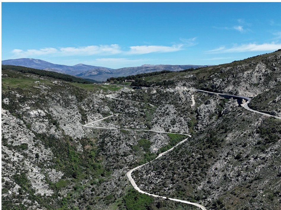
Figura 1. Vista general de la parte alta de la vertiente meridional del Puerto del Pico. Fotografía de Santiago Úbeda.
