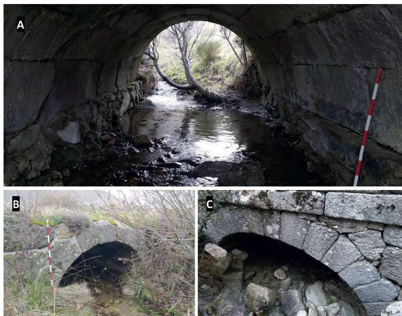
Figura 10. A y B, pontones de medio punto en el Puerto de Menga. C, pontón rebajado en el Puerto del Pico. Fotografías del autor.
